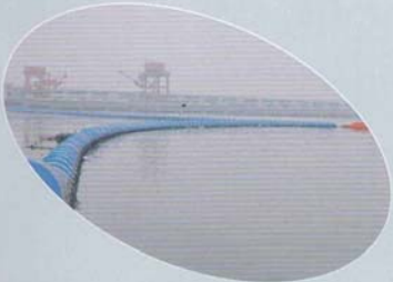
首次用超高分子量聚乙烯绳使用于长江水电阻拦网工程 The hydropower block network project of Yangtze River.
